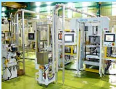
トランスミッション関連設備
